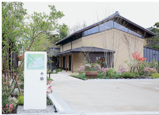
KIKUSUI蔵GARDENの外観
