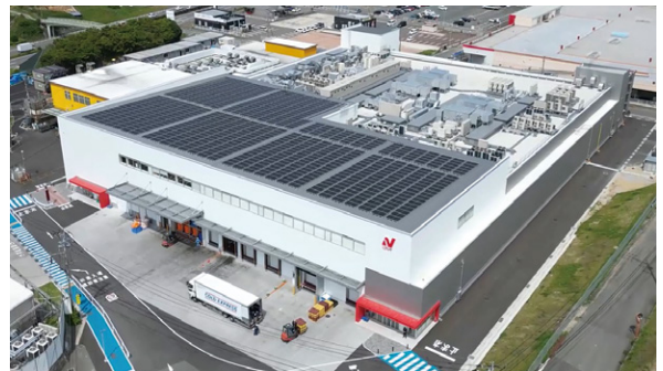
太陽光パネル
